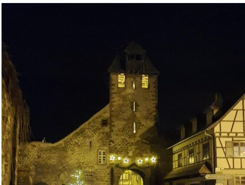
Wangen et sa Niedertor : un solide coup de pouce de la « mission Bern ». Photo DNA Une fois restaurées, les berges pourront accueillir du public. Photo DNA.
