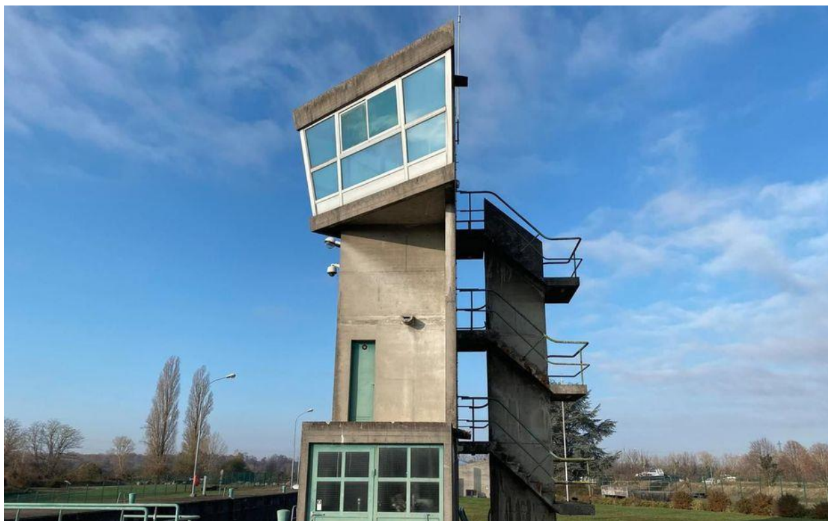
Kembs-Niffer (Haut-Rhin). La rénovation des bâtiments de l'écluse nécessite 800 000 euros. Un appel aux dons a été lancé pour boucler le budget. LP/Martin Antoine
