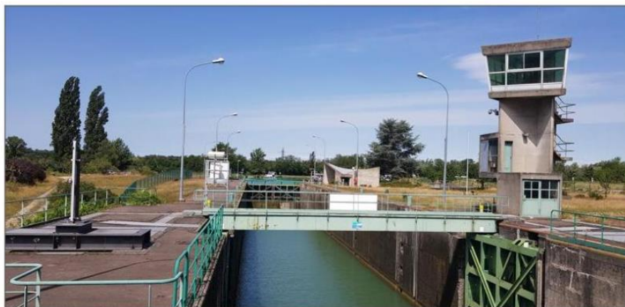
La tour de commande et le bâtiment d'exploitation (en arrière-plan) de l'écluse de Niffer pourront à nouveau être visités une fois réhabilités. Photo DNA/Karine DAUTEL
