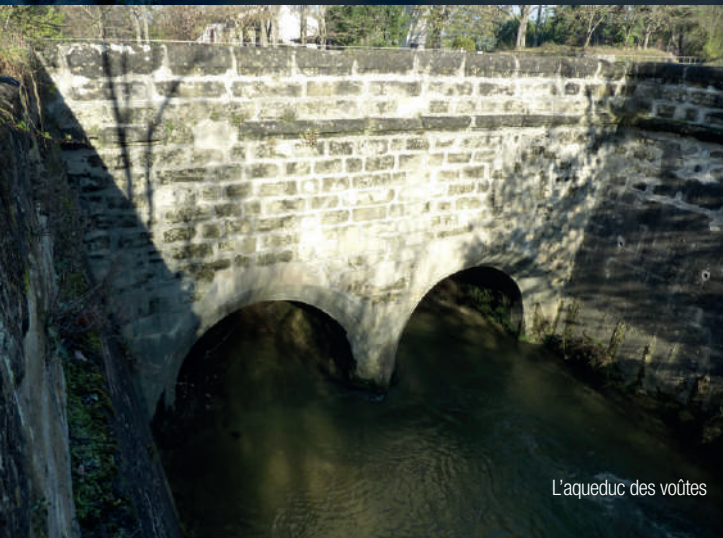
Le pont canal de Briare
