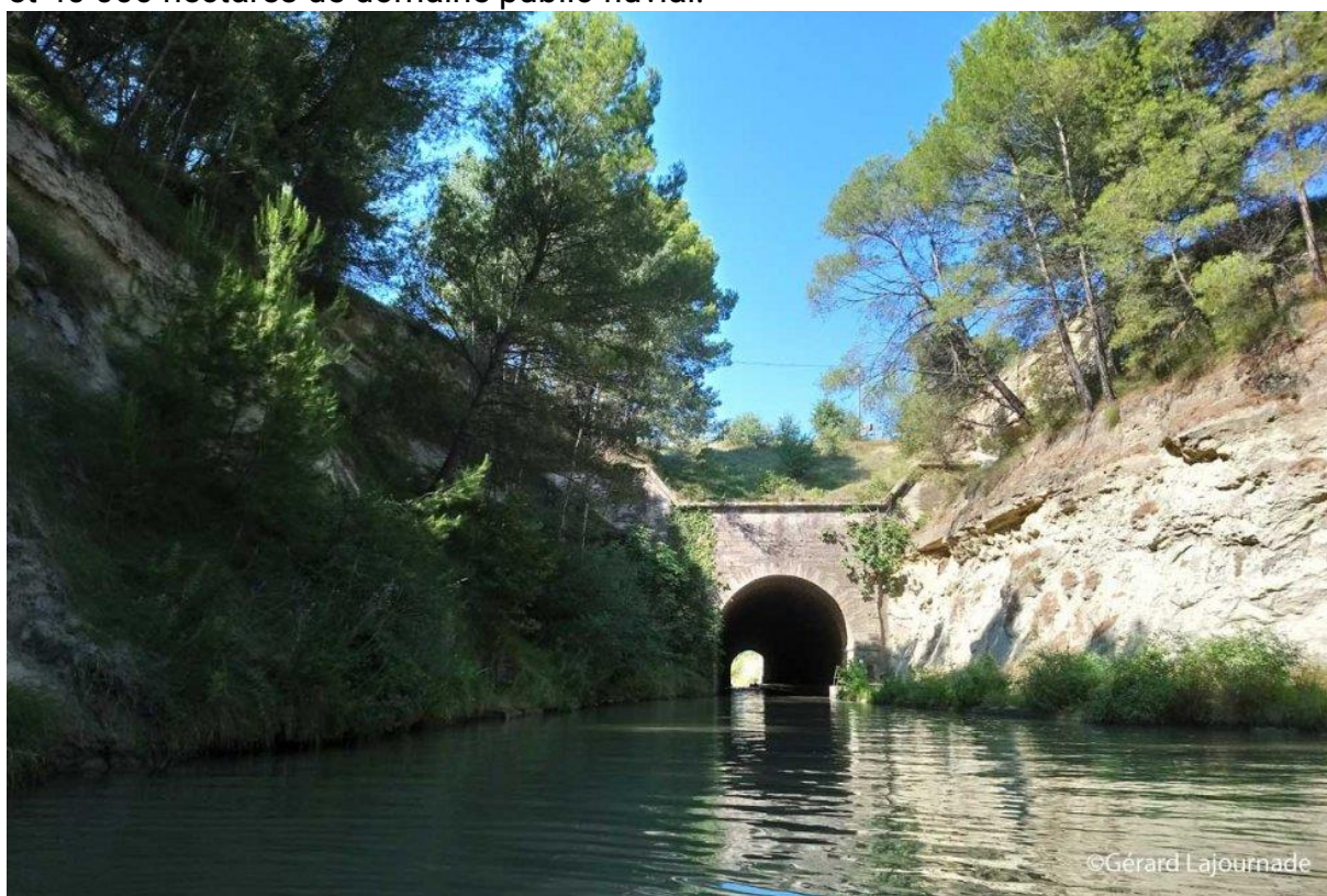
Tunnel de Malpas au pied de l'oppidum d'Ensérune, un des 400 ouvrages d'Art du Canal du Midi
