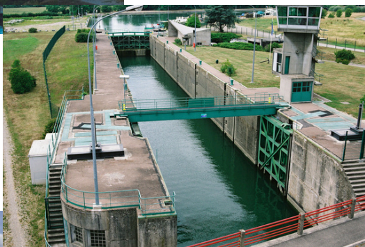
Ecluse de Le Corbusier
