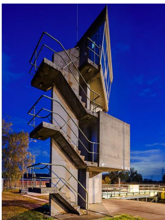
La rénovation des bâtiments Le Corbusier coûteront 1,9 million d'euros, financés par le mécénat de VNF. (DR)
