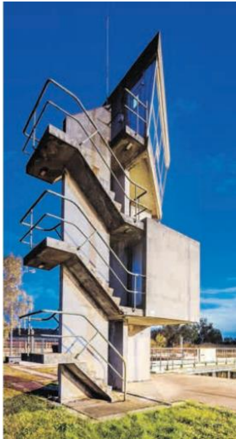
L'emblématique tour de contrôle de l'écluse de Kembs-Niffer (Haut-Rhin), une curiosité architecturale en danger. Alexandra Lebon
